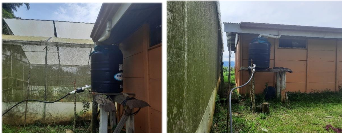
Figura 28. Productor implementando cosecha de agua, de las canoas de la casa en un tanque, para riego del invernadero
