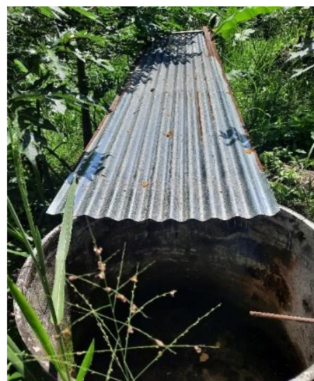
Figura 26. Productor implementando cosecha de agua de lluvia en un tanque, por medio de una lata de zinc
