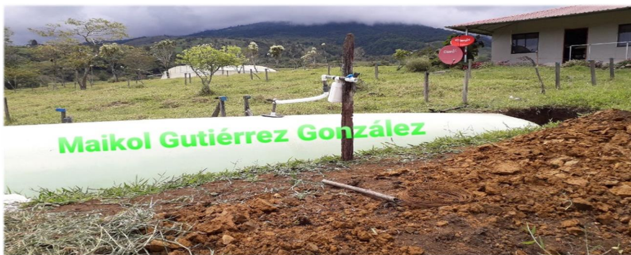
Figura 78. Instalación de biodigestores para el manejo de remanentes en fincas pecuarias para disminuir la producción de GEI y la contaminación del río Reventazón
