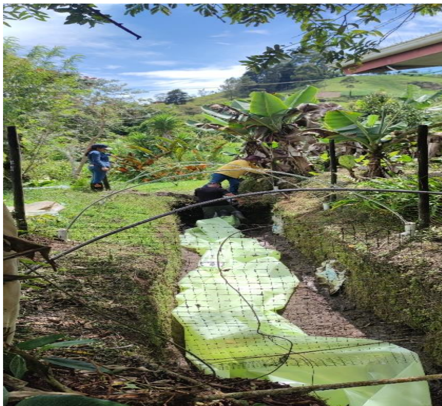
Figura 79. Instalación de biodigestores para mejorar el manejo de remanentes en fincas pecuarias
